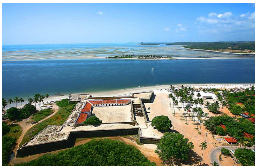
Figura 4. Forte Santo Orange no contexto da paisagem do Litoral Norte – Foto: Rafael Medeiros
