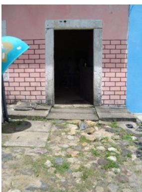
Foto 4 – Porta de Acesso Fonte: CL Engenharia e Urbanismo
