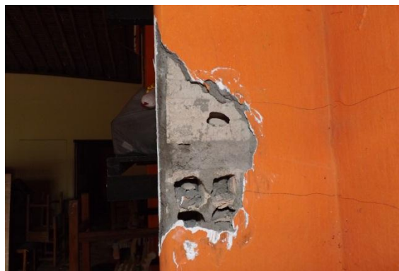
Foto 19 Observar coloração da argamassa, acinzentada por causa do teor de cimento
