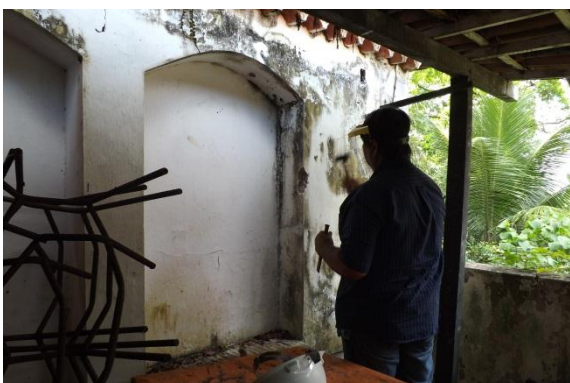
Foto 26 – Início da prospecção na parede da oficina – Lateral direita Fonte: CL Engenharia e Urbanismo
