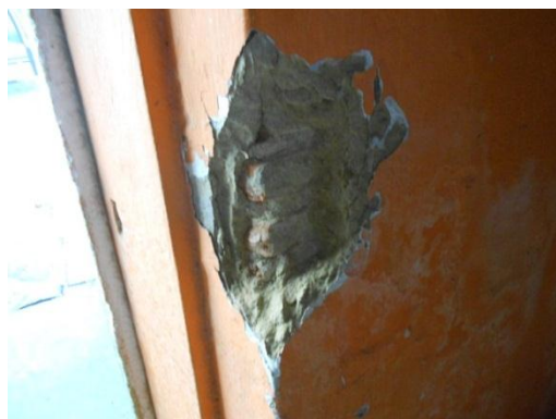
Foto 12 – Prospecção na alvenaria frontal
