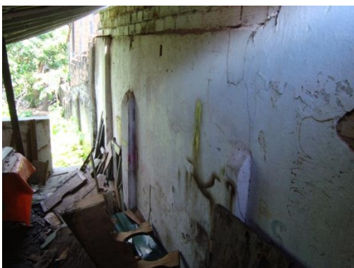
Foto 24 – Início da prospecção na parede da oficina Fonte: CL Engenharia e Urbanismo
