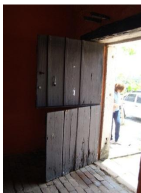
Foto 5 – Detalhe da porta de acesso Fonte: CL Engenharia e Urbanismo
