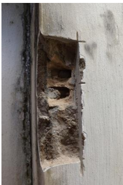
Foto 28 – Detalhe da alvenaria direita no espaço da oficina.
