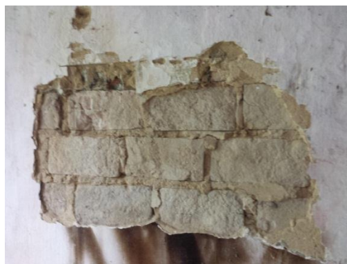
Foto 25 Observar detalhes da disposição dos tijolos Fonte: CL Engenharia e Urbanismo
