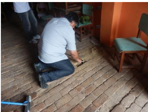
Foto 22 – Início da prospecção no piso Fonte: CL Engenharia e Urbanismo
