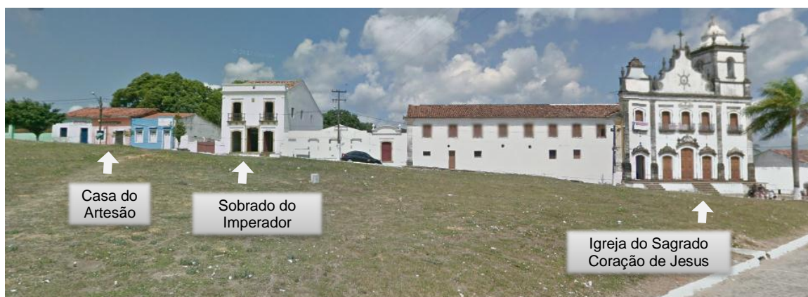
Foto 1 – Trecho da Rua Barbosa Lima
