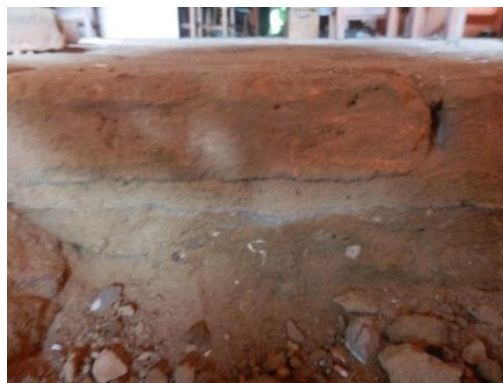
Foto 23 Observar detalhes dos estrados do solo. Solo batido, contrapiso, argamassa e tijolo Fonte: CL Engenharia e Urbanismo
