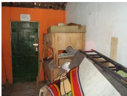
Foto 39 – Entulho na Circulação Fonte: CL Engenharia e Urbanismo
