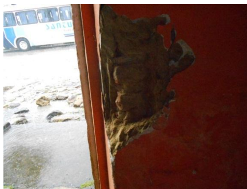
Foto 13 – Mesma janela mostrando detalhe do reboco e elementos da alvenaria
