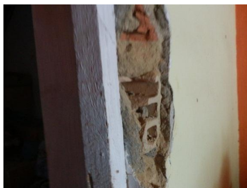
Foto 21 Observar tijolos de furos e reboco em argamassa de cimento e areia
