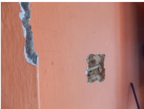
Foto 14 – Janela aberta na parede lateral esquerda Fonte: CL Engenharia e Urbanismo
