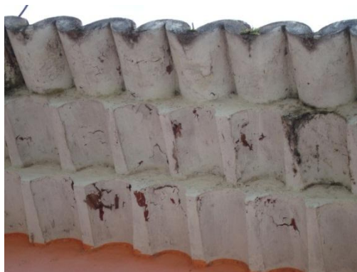
Foto 3 – Detalhe do beiral Fonte: CL Engenharia e Urbanismo
