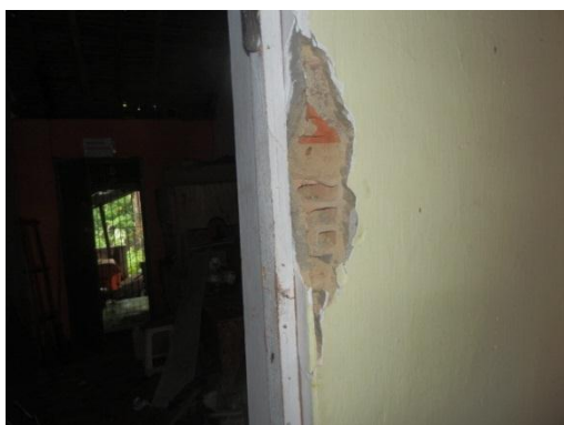
Foto 20 – Imagem da prospecção na alvenaria dos fundos.
