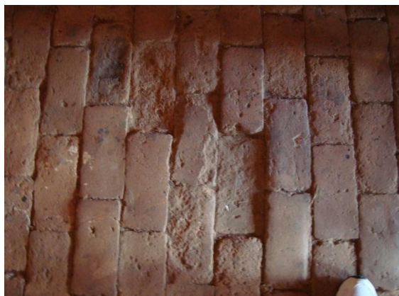
Figura 1 – Retirar as peças mais danificadas. Fonte: CL Engenharia e Urbanismo.
