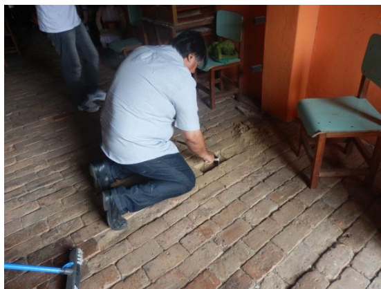
Figura 2 – Com o devido cuidado quebrar a peça danificada e retirar o entulho. Fonte: CL Engenharia e Urbanismo.
