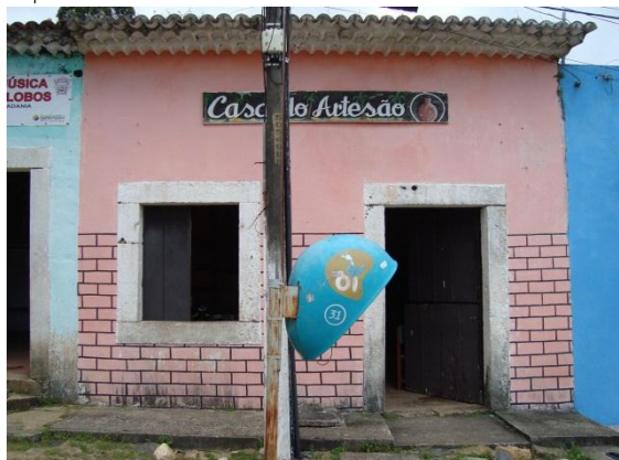
Figura 19 – Cercaduras de porta e janela em cantaria revestidos de tinta à cal. Fonte: CL Engenharia e Urbanismo.
