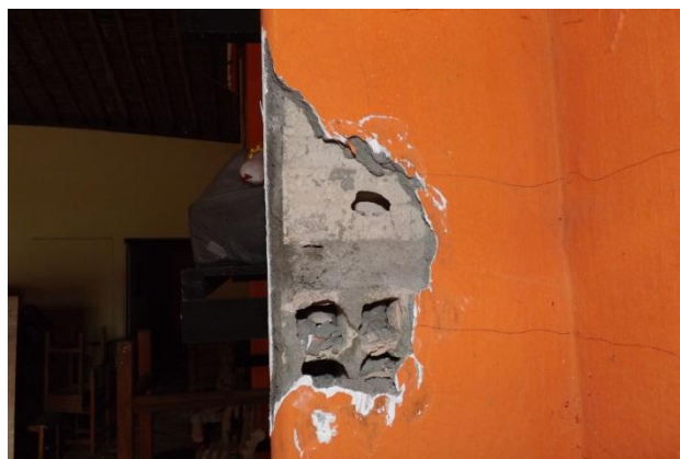
Figura 8 – Prospecção de um dos pilares estruturais do telhado. Traço forte da argamassa de assentamento e reboco. Fonte: CL Engenharia e Urbanismo.
