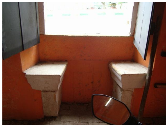
Figura 20 – Conversadeiras em cantaria também pintadas à cal. Fonte: CL Engenharia e Urbanismo.
