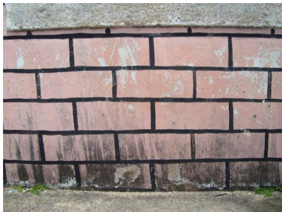
Figura 18 – Detalhe da pintura na fachada. Fonte: CL Engenharia e Urbanismo.
