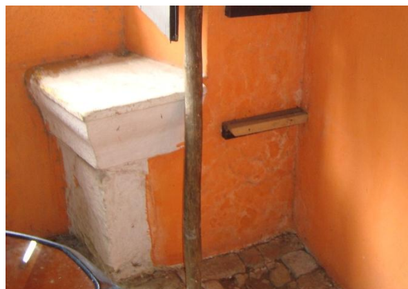
Figura 24 – Detalhe da pintura na fachada.
