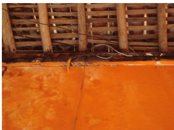
Figura 13 – Vista da face inferior da cobertura. Linhas mais escuras pelo provável uso de bioxênio. Fonte: CL Engenharia e Urbanismo.
