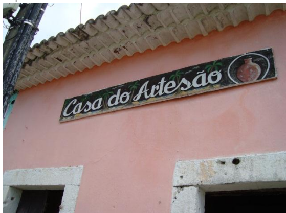
Figura 17 – O conjunto de beira, sob-beira e bica em perfeito estado de conservação. Fonte: CL Engenharia e Urbanismo.
