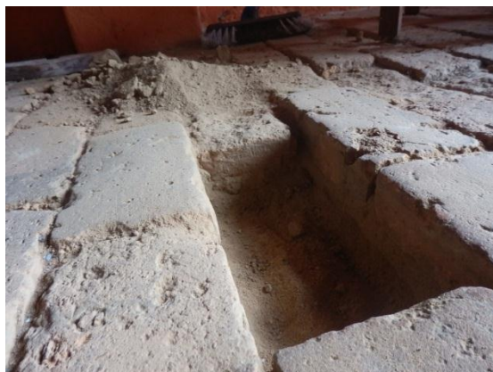
Figura 4 – Umedecer e lançar a argamassa com posterior assentamento da unidade, sem rejunte. Fonte: CL Engenharia e Urbanismo.
