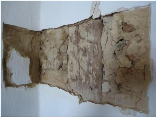
**Foto 37 – À esquerda nova alvenaria, à direita alvenaria de pedras, esteio e alvenaria mista**
