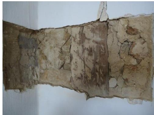
Foto 32 – À direita alvenaria mista com estrutura de madeira. À esquerda boneca em alvenaria da abertura para o espaço contíguo.
