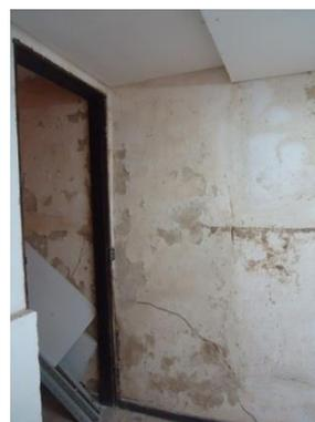
**Foto 94 – Desprendimento do revestimento em função da umidade**
