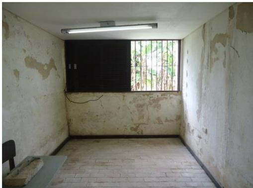
**Foto 95 – Desprendimento do revestimento em função da umidade**
