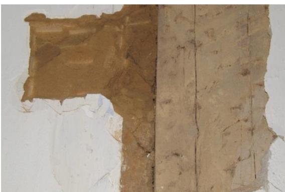
**Foto 45 – Detalhe do esteio e a alvenaria de taipa**
