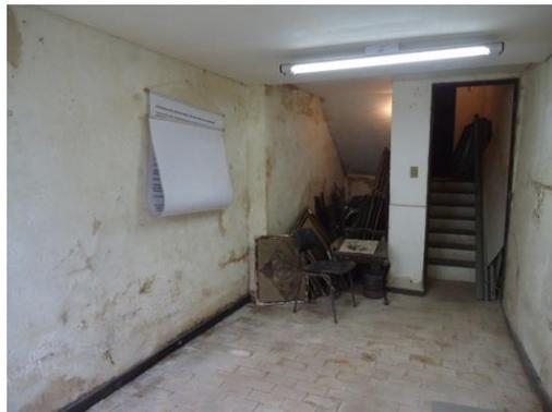
**Foto 96 – Desprendimento do revestimento em função da umidade**
