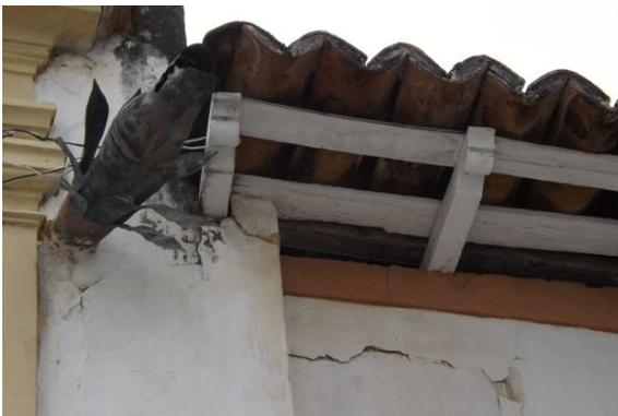
**Foto 92 – Rachaduras próximas ao telhado**
