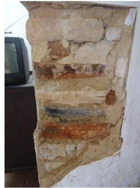
**Foto 34 – Alvenaria apresentando detalhes de corte mecânico.**
