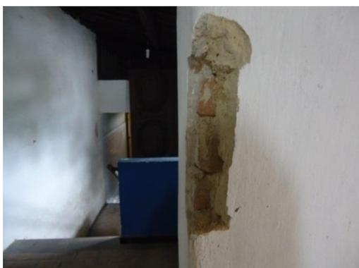
Foto 57 – Detalhe da ombreira – alvenaria de tijolos
