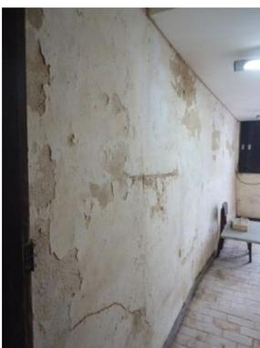
**Foto 93 – Desprendimento do revestimento em função da umidade**
