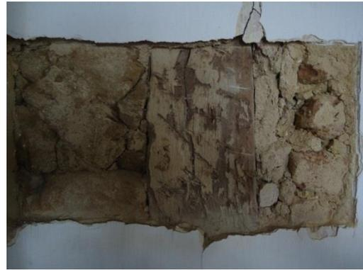
**Foto 38 – Esquerda alvenaria de pedras, ao meio esteio em madeira e à direita alvenaria mista**
