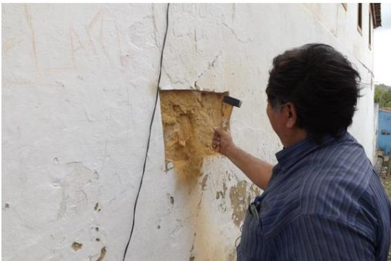
Foto 88 – Verificação da profundidade da rachadura
