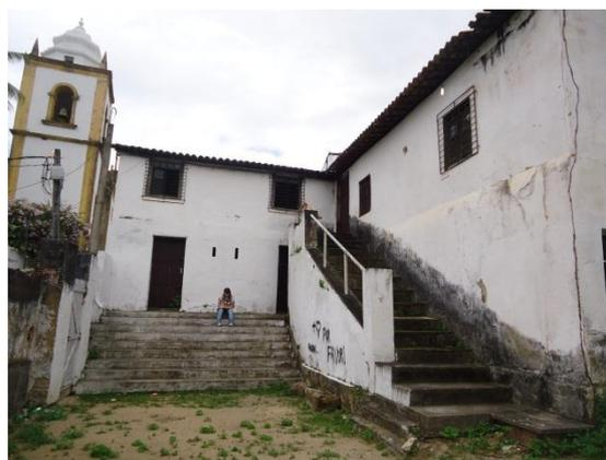
Figura 10– Vista frontal da cobertura de três águas e lateralmente o telhado do anexo em meia água.
