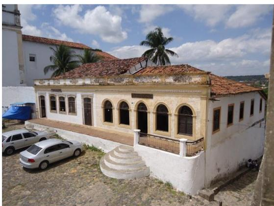
Figura 09– Vista das coberturas do conjunto. À esquerda no nível mais alto em duas águas, à direita mais baixo em três águas.
