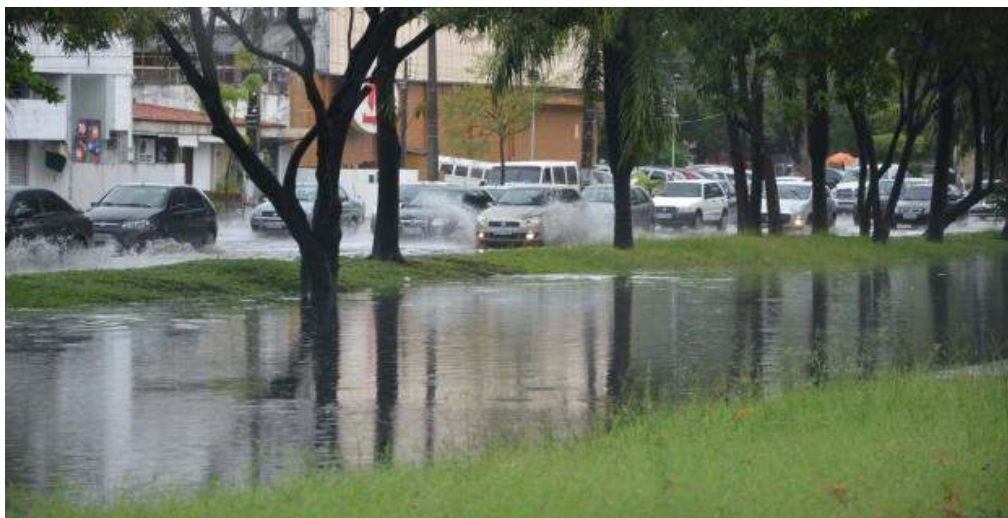
Foto 16: Aspectos da drenagem da Av. Agamenon Magalhães, em manhã de chuva intensa coincidindo com a máxima preamar.
