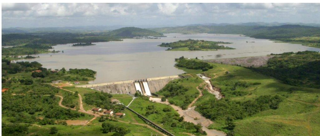
Foto 13: Sistema de Abastecimento de Água da RMR, Barragem Tapacurá.
