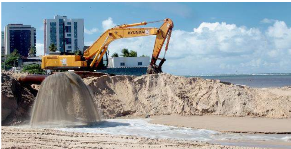
Foto 7: Aspectos da engorda das praias de Jaboatão dos Guararapes.
