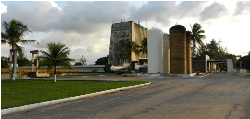
Foto 14: Estação de Tratamento de Água do Sistema Tapacurá.
