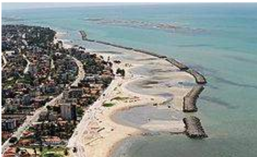
Foto 3: Enrocamento construído na Praia do Janga, em Paulista.
