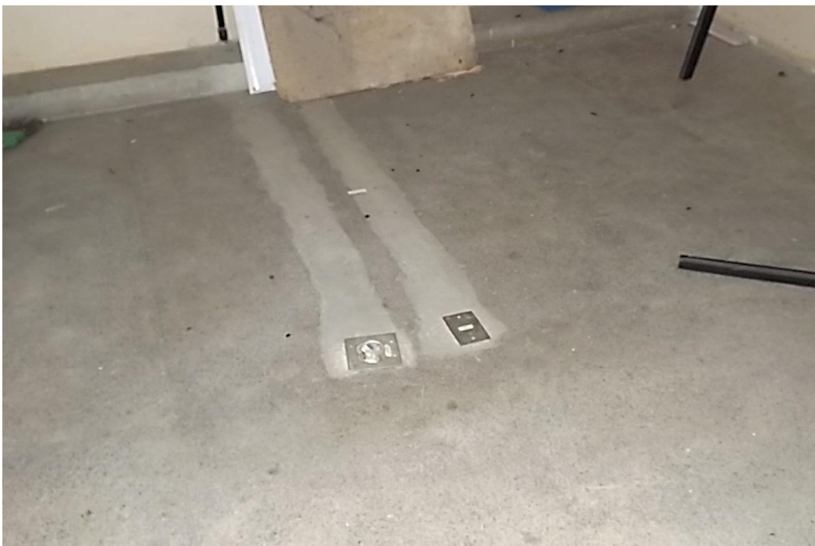
Figura 2 – Piso de granilite do 1º pavimento
