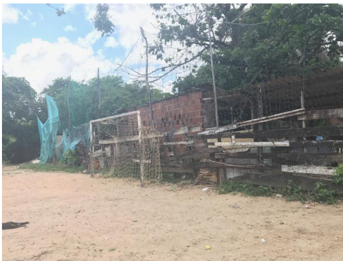
Figura 12: Acesso imóvel voltado para o Campo
