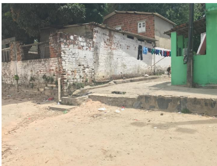
Figura 6: Calçada com Desnível
