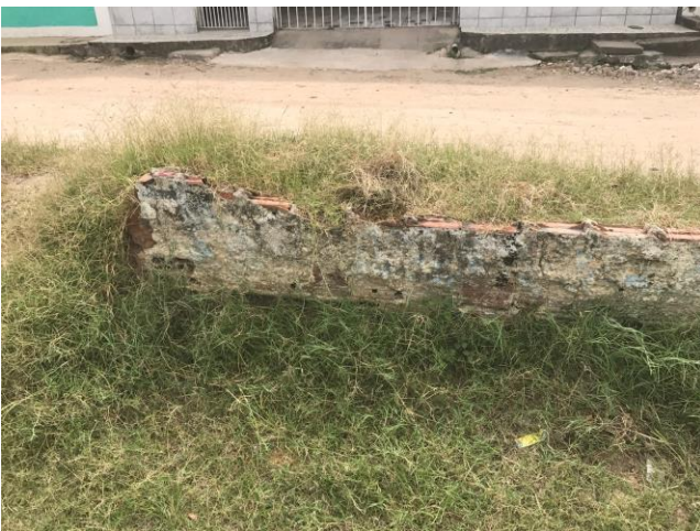
Figura 13: Mureta existente á demolir
