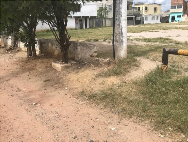
Figura 11: Mureta existente mantida
