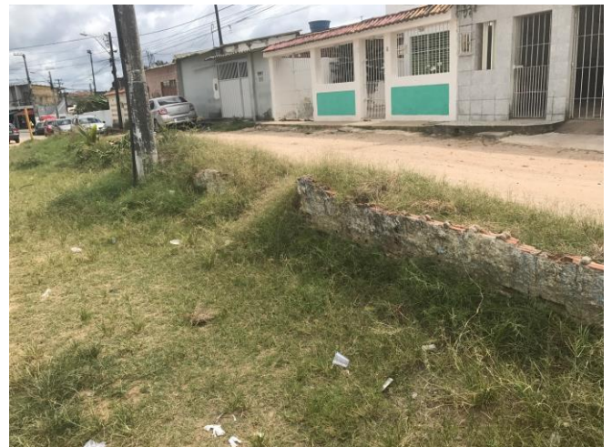
Figura 14: Mureta existente à demolir
