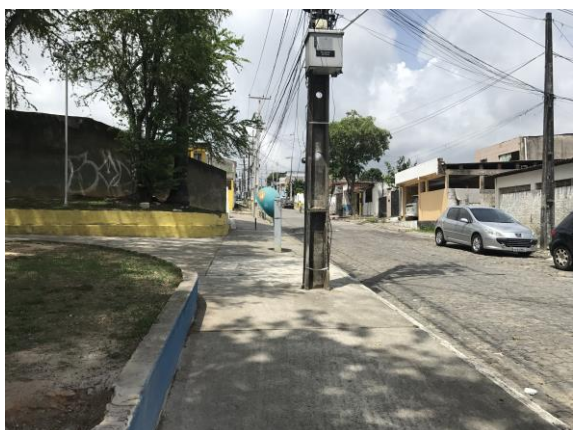
Figura 4: Desnível em relação à calçada. Fonte: Colmeia, 2018.
