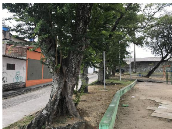
Figura 3: Muretas de contenção dos canteiros. Fonte: Colmeia, 2018.
