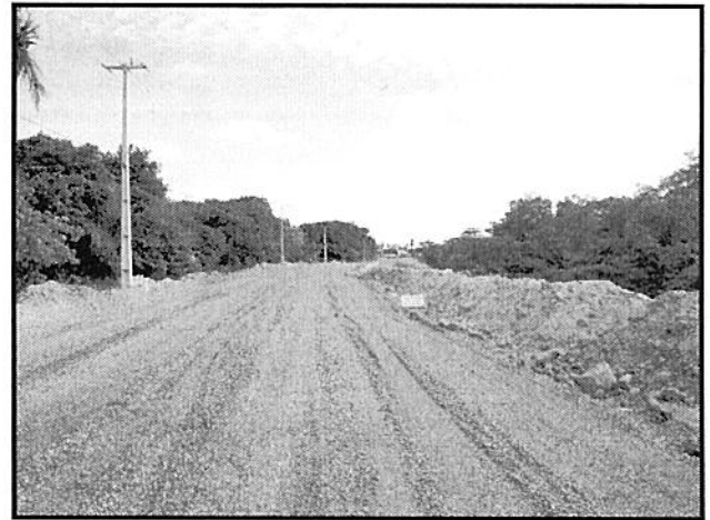
Figura 09. Detalhe do manguezal margeando a rodovia.
