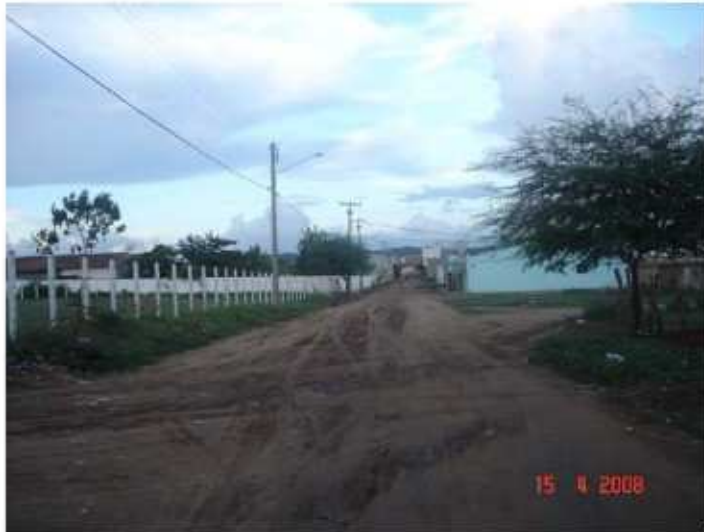
Foto 05 - Rua Maria Pereira da Rocha
